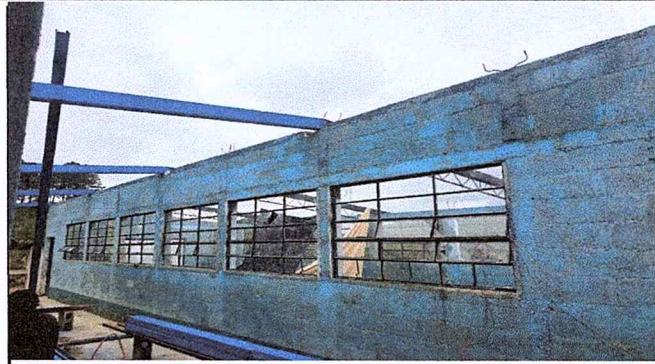
Foto 2: Instalación de estructura de techo.
