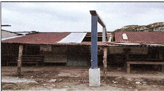
Foto1: Instalación de estructura para corredor.
