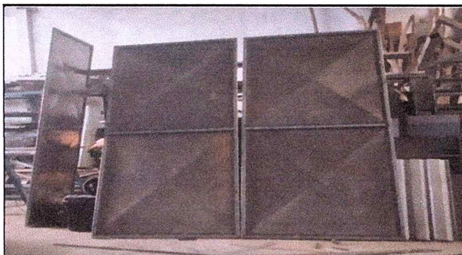
Foto 3: Elaboración del la división metálica.
