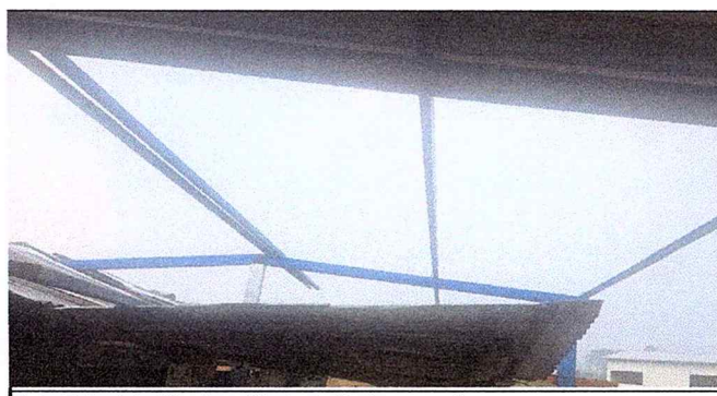
Foto 5: Instalación de cubierta de lámina en aula.
