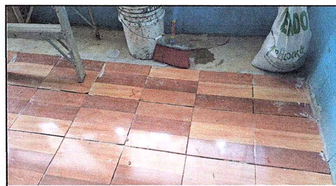
Foto 6: Instalación de piso cerámico en dirección.
